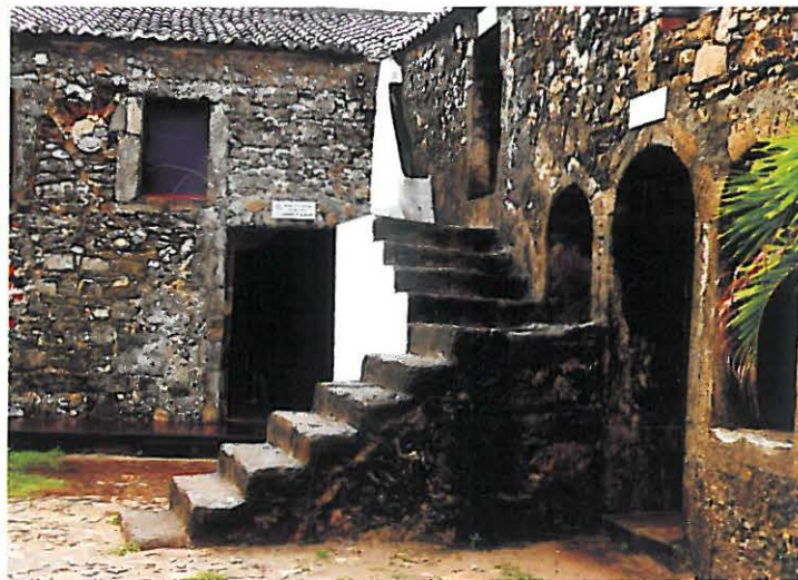
Abertura frontal que deve ter sido a terceira casa de pólvora. Encontramos vestígios de um piso em madeira. À direita, escada obstruindo uma das aberturas em arco e que permite o acesso a uma cisterna, construída em seguida.
